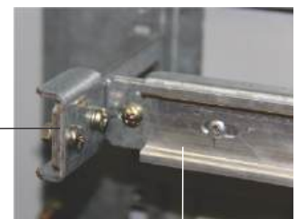
Suporte Horizontal com perfil DIN para fixar disjuntores bornes
